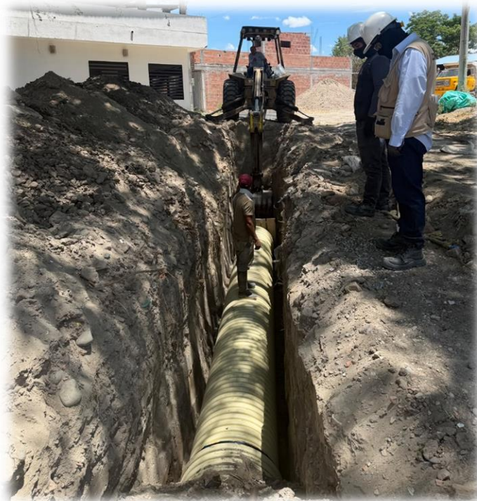
Foto 6. Instalación red de alcantarillado
