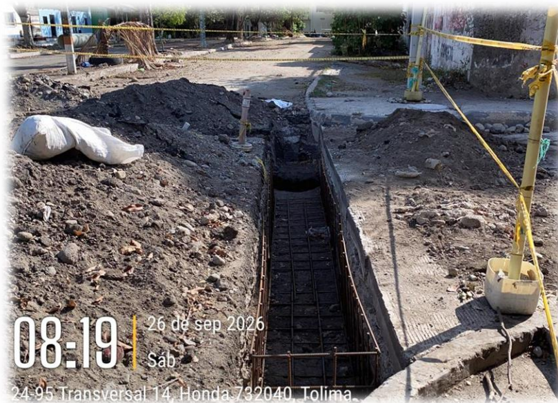
Foto 13. Instalación de acero de refuerzo
