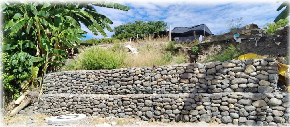
Foto 7. Construcción Gaviones
