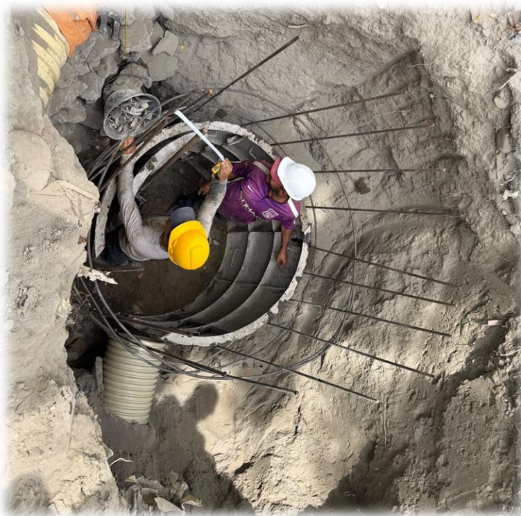
Foto 1. Construcción Pozo de inspección
