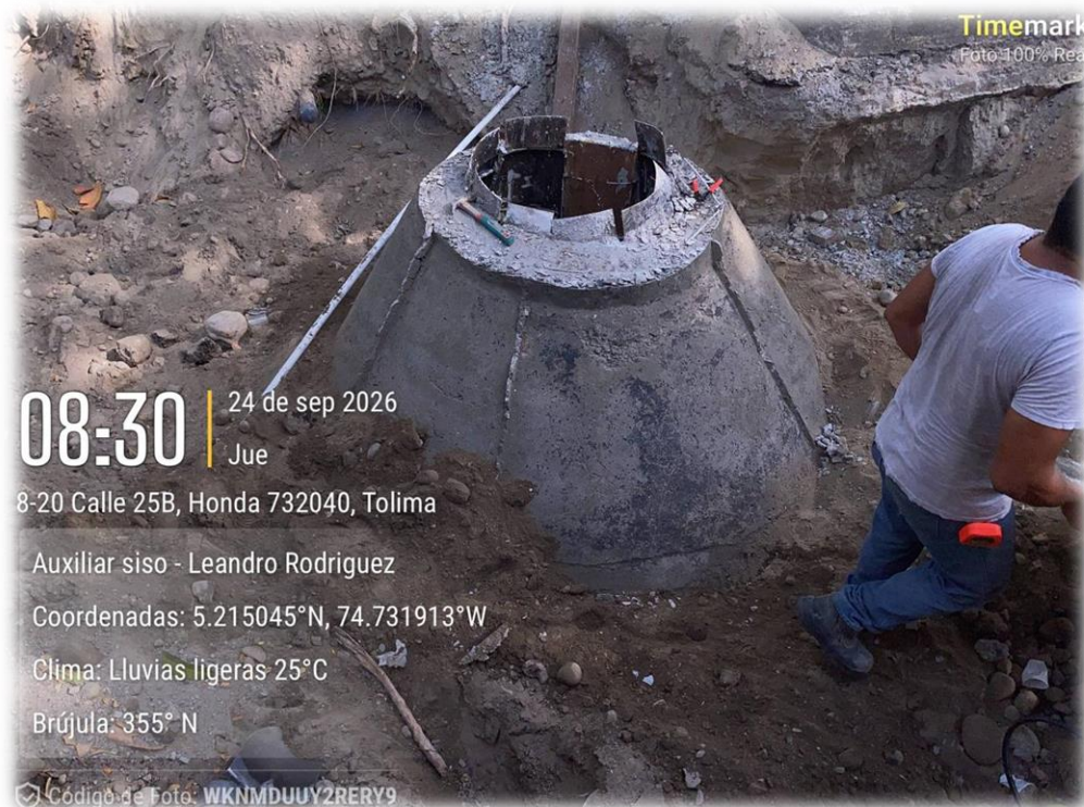
Foto 11. Construcción Pozos de inspección
