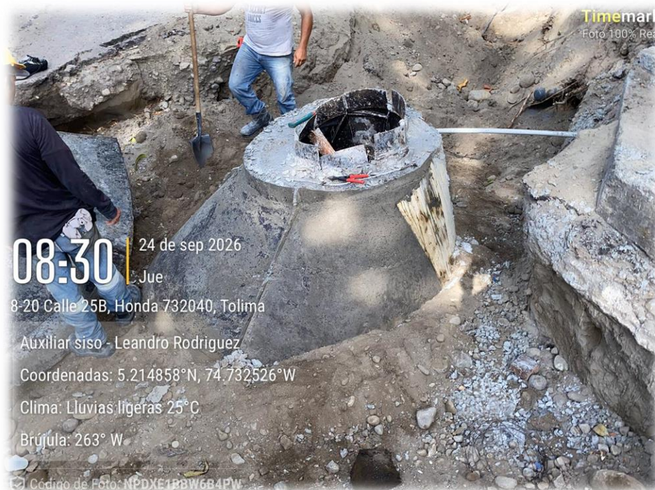
Foto 11. Construcción Pozos de inspección
