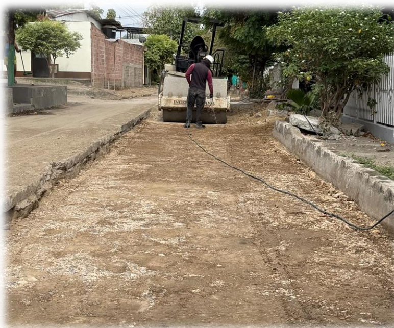
Foto 4. Compactación posterior instalación de red de alcantarillado
