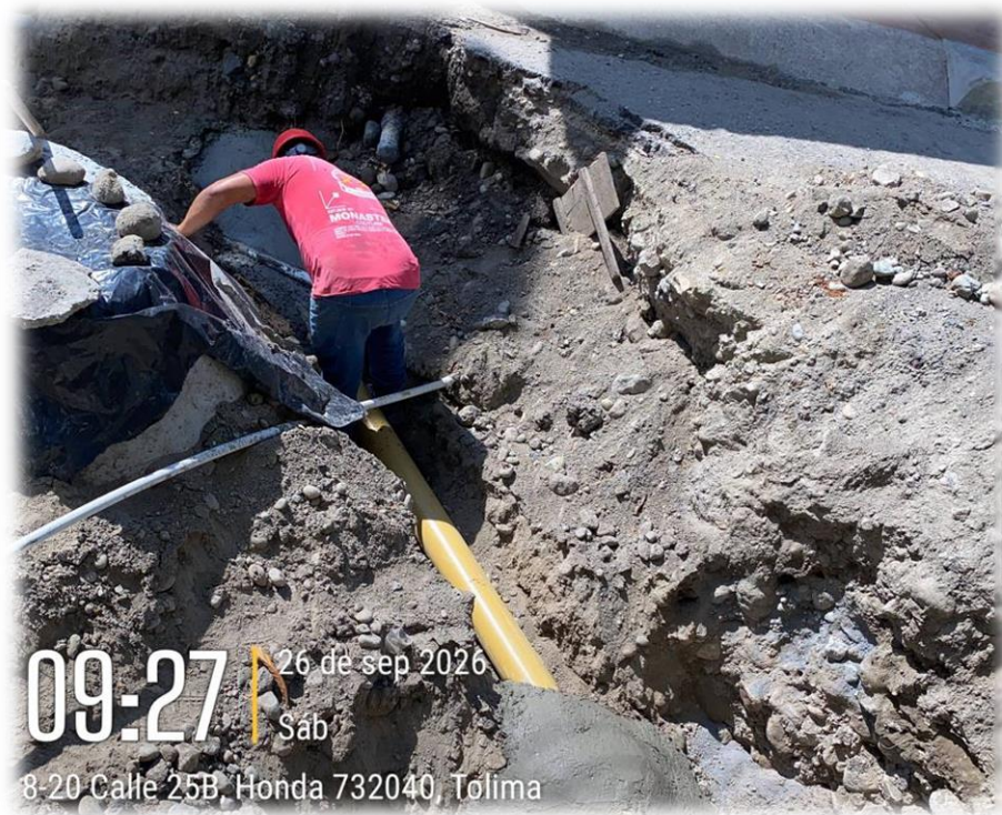
Foto 12. Instalación Tubería Domiciliaria
