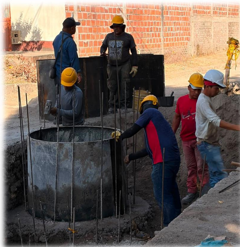
Foro 3. Construcción de pozo de inspección
